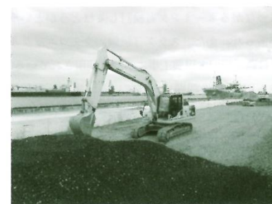
石炭灰の利用例（改良盛土材など）
