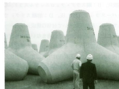
石炭灰の利用例（消波ブロック製作）
