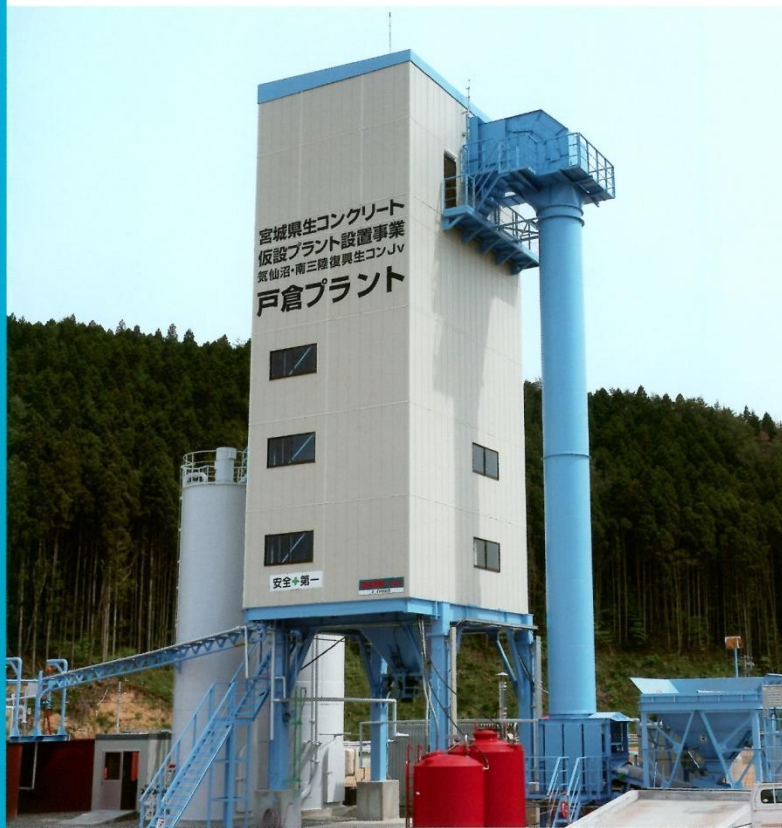
宮城県指定工事への安定供給を通じ地場産業再建に貢献する 気仙沼・南三陸復興生コンJV 戸倉 プラント (日工製)
