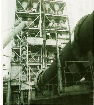
1年足らずで完了した旧船渡工場
