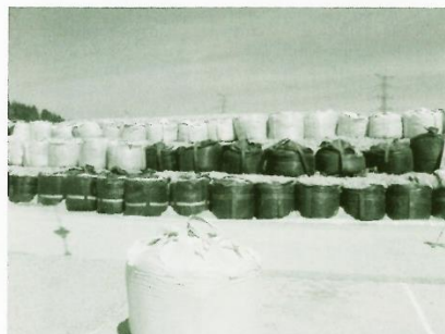
図4 宮城県環境事業公社で行われている飛灰の埋立処理の様子(2013/5/18)
