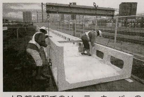
JR都城駅でのソーラーキーパーの据え付け状況
