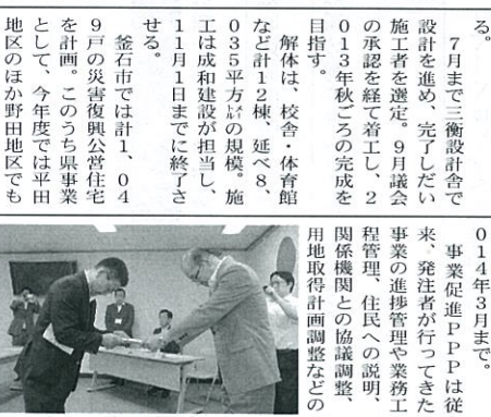
復興公営住宅の第1弾、釜石市平田地区で着工式が行われた。平田地区では、旧東松島市商業地区を解体跡地に公営住宅を建設する計画で、近く解体工事に着手する。
