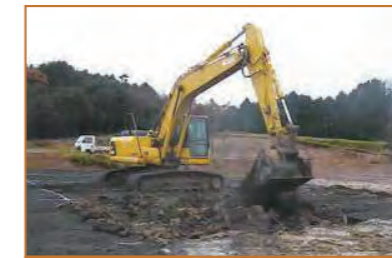
造成工事(バックホウ使用)
