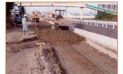
道路拡幅部盛上げ(バックホウ使用)
