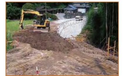
道路用盛土(バックホウ使用)
