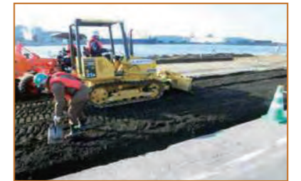
岸壁盛上げ用路床材(カルスピ工法使用)
