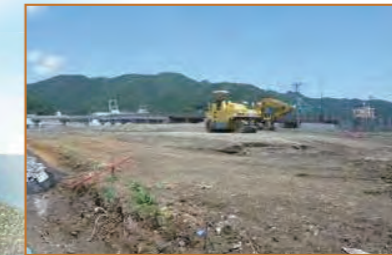
海岸防潮堤の遷移(カルスピ工法使用)
