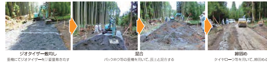
重機にてジオタイザーを所要量敷き均す | バックホウ等の重機を用いて、原土と混合する | タイヤロープ等を用いて、締固める
