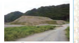
改良土の敷置き状況
