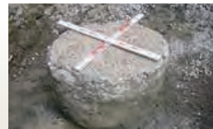
SCP杭の打設状況
