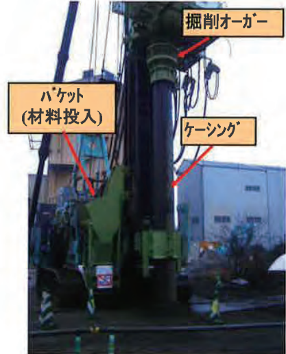
静的圧入工法による施工状況（Geo-KONG工法）
