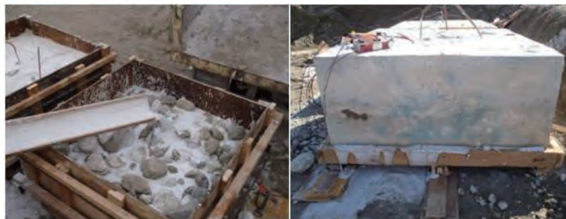
海水浸漬瓦礫を用いたプレキャストコンクリート打設
