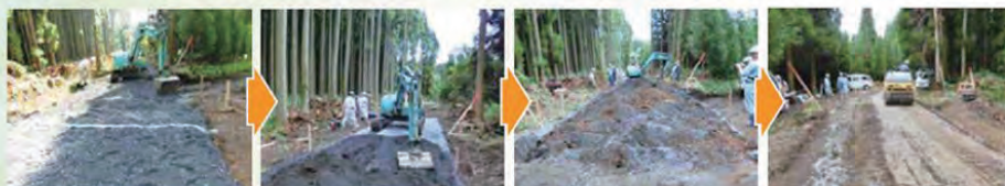
ジオタイザー敷均し 重機にてジオタイザーを所要量敷き均す 混合 バックホウ等の重機を用いて、原土と混合する 締固め タイヤローラ等を用いて、締固める
