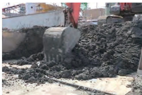
写-1 シールド泥土
