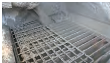
写-4 処理土排出状況
