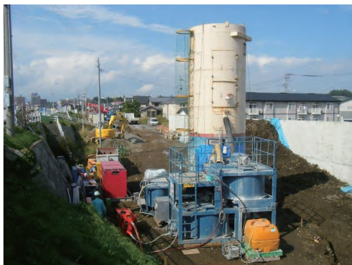
残置管充填施工写真
