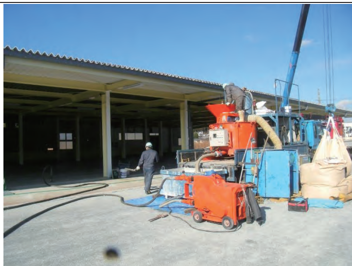
床下充填施工写真
