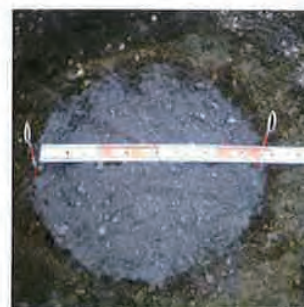
スマートコンパクションで 造成した杭(製鋼スラグ)
