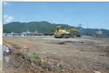
海岸防潮堤の堤体(カルスピン工法使用)
