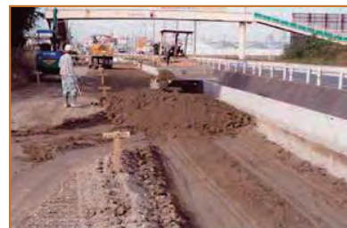
道路拡幅部盛上げ(バックホウ使用)
