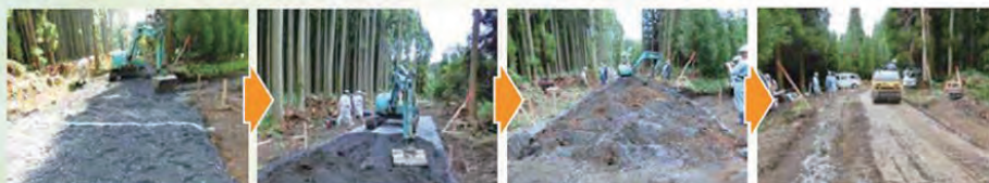
ジオタイザー敷均し 重機にてジオタイザーを所要量敷き均す
