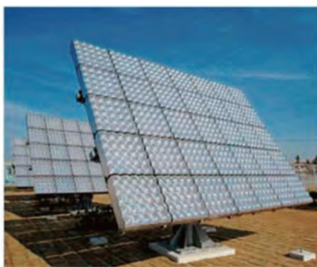
図表 14 集光型太陽光発電システム例
