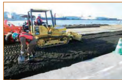
岸壁盛上げ用路床材(カルスピン工法使用)
