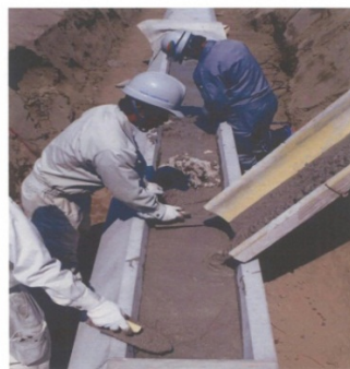
モルタル投入
