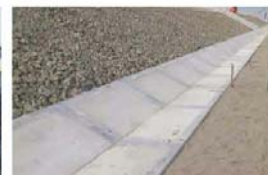
中詰め打設完了
