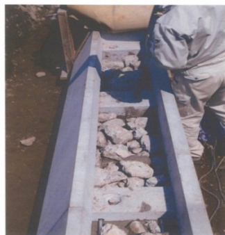
中詰め材投入 (コンクリート破)
