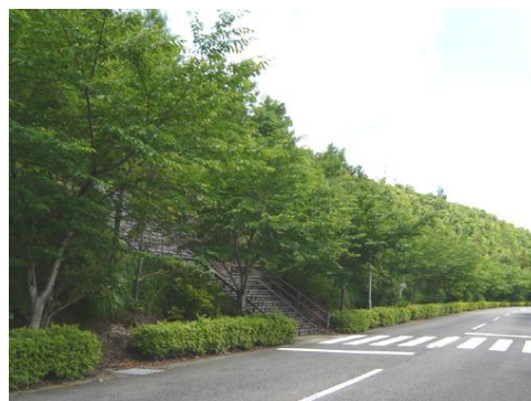
播種工・植栽工の併用による緑化
