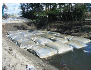
写真1 冠水箇所への盛土状況
