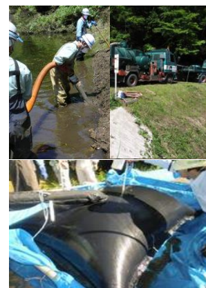
写真2 袋への充填状況
