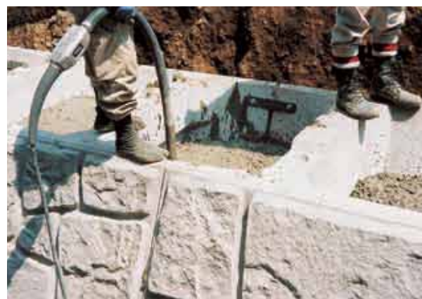
胴込めコンクリートの締固め
