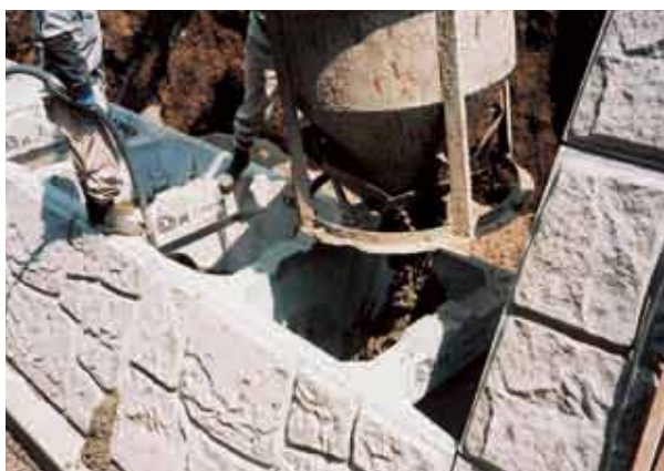
胴込めコンクリートの打設
