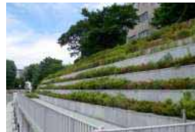
施工断面例(もたれ式階段積み擁壁)
