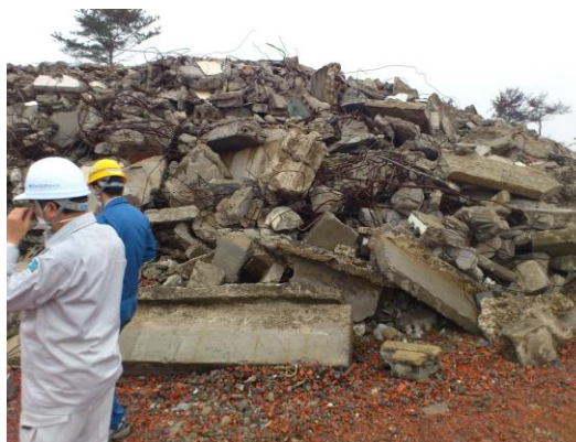
図-1 震災コンクリートガラ (仙台蒲生地区)
