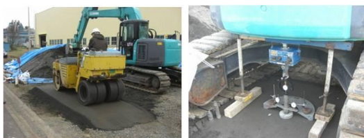
写真3 現場締固め試験と現場 CBR の測定
