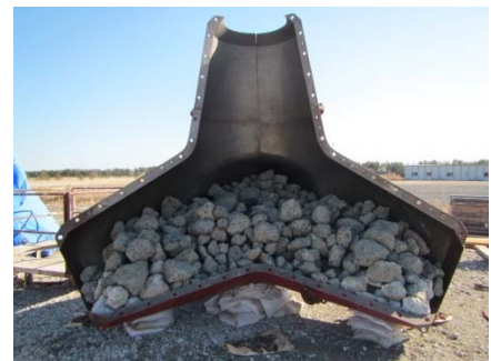
写真-4 がらの投入状況
