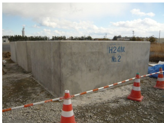
写真-8 根固めブロックの全景
