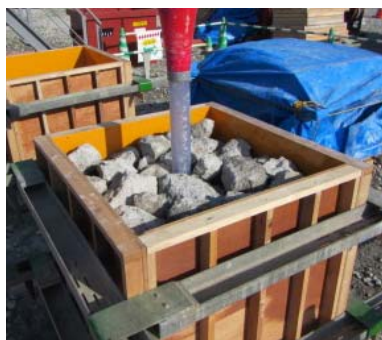
写真-5 品質管理用ブロックの作製状況
