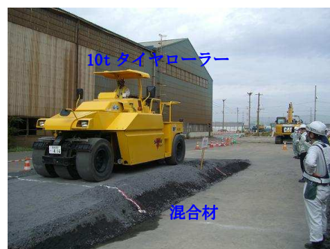
写真-3 転圧状況
