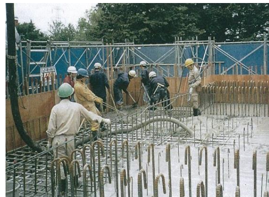
図 4 放射線治療室躯体打設
