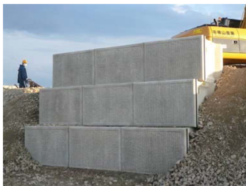
写真-4 コンクリートがれき、陶磁器くず、津波堆積土砂を中詰材としたエコボックスのモデル施工
