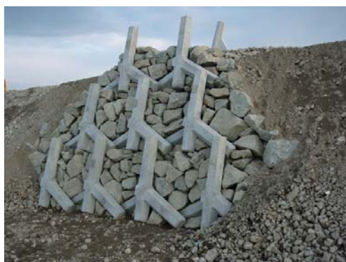
写真-5 石材（前面のみ）と中詰材にコンクリートがれきを使用したブランチブロックのモデル施工
