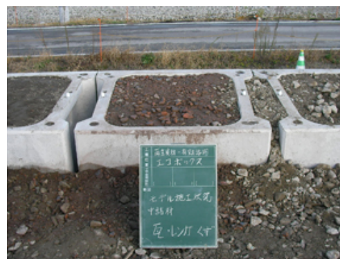
写真-4 コンクリートがれき、陶磁器くず、津波堆積土砂を中詰材としたエコボックスのモデル施工
