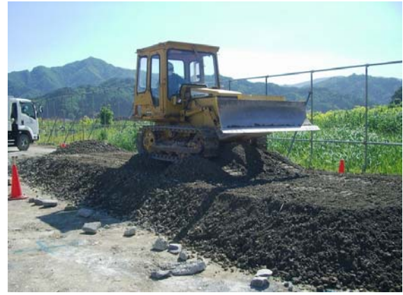
写真-6 ブルドーザによる敷均し状況
