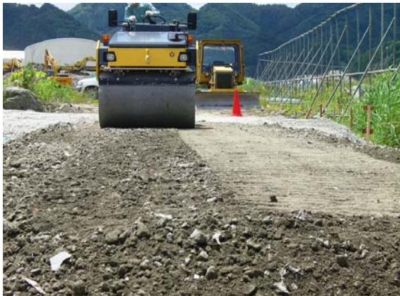
写真-7 振動ローラーによる転圧締固め状況
