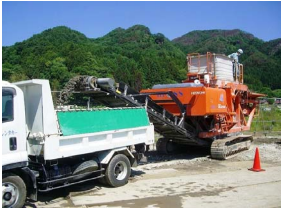
写真-5 移動式ミキサーによる混合状況
