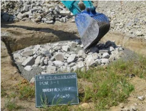
写真5 ポストパクト方式打設状況
