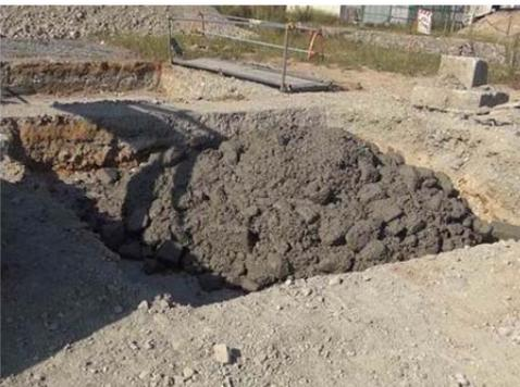
写真6 プレミクス方式打設状況
