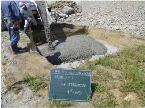
写真4 複合流動体の打設
