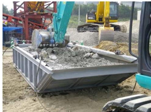
写真 2 粗粒コンクリート塊の混合状況
