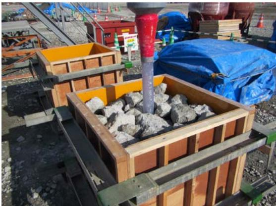
写真-7 ブロックの作製状況 (プレパックドコンクリート)
