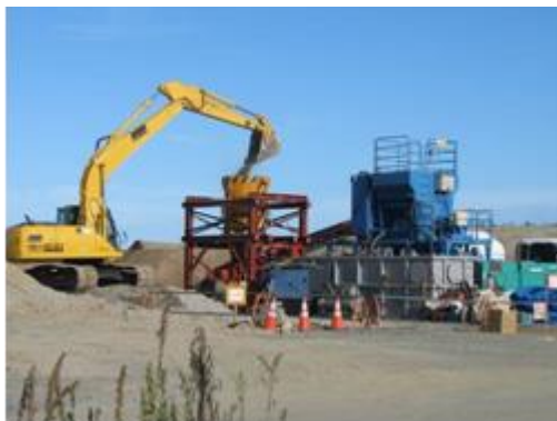
写真－1 試験施工における製造プラント
