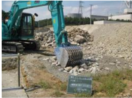
写真-5 ポストパクト方式による打設
