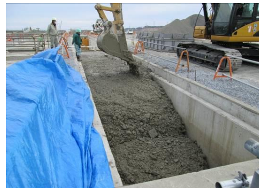
写真-11 粗粒材混合体の打設状況
