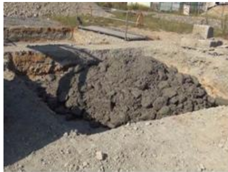
写真-6 プレミクス方式による打設
