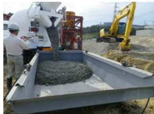
写真－2 ガランダム流動体の荷卸し
