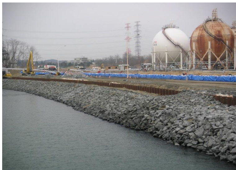
写真－3 災害復旧工事 施工状況
