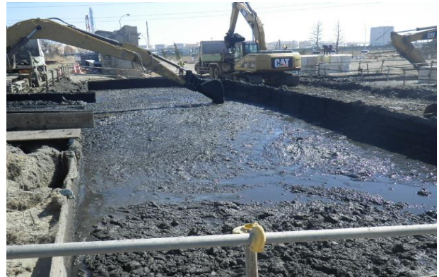
図-17 砂押川での土砂ピットでの雑物除去状況
