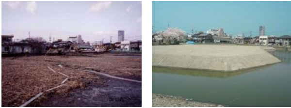
図-15 施工状況(芳賀池地区造成工事) 左:ヘドロ堆積状況,右:平成16年人工地盤完成
