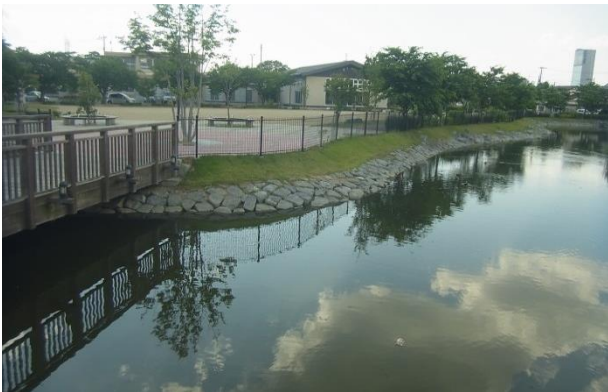
図-16 ポンテラン改良土による親水公園
