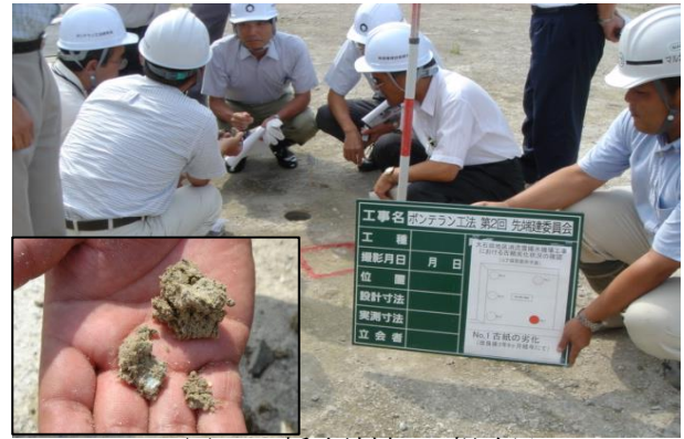
図-12 採取試料の目視確認
