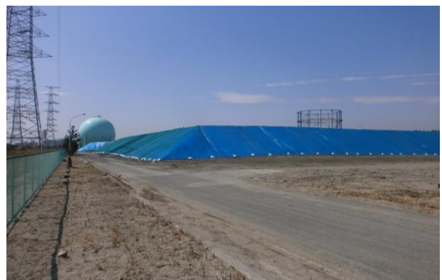
図-18 砂押川におけるブルーシートを用いた仮置き状況
