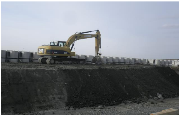
図-20 養生1日で0.7m 3 級BHによる締固めが可能
