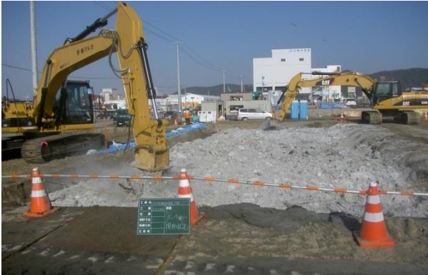
図-19 石巻西港におけるボンテラン改良状況
