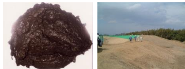
図-13 施工状況(浜尾遊水地) 左:有機質土, 右:平成 14 年築堤完了
