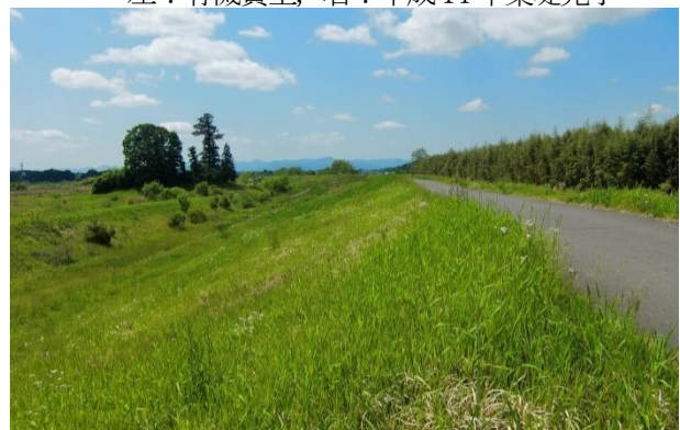
図-14 平成 25 年撮影ボンテラン改良土による施工箇所
