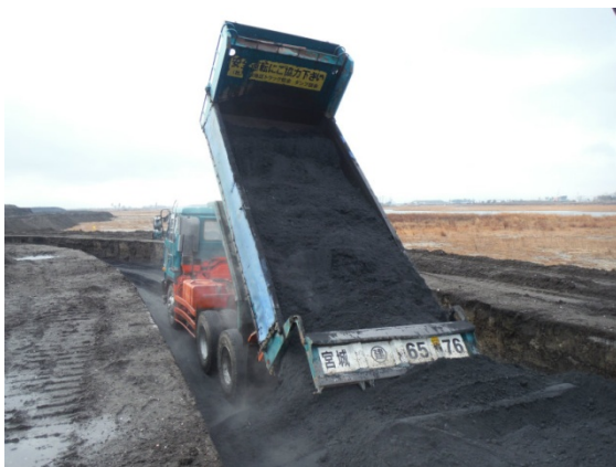
焼却主灰造粒固化処理物の荷卸し
