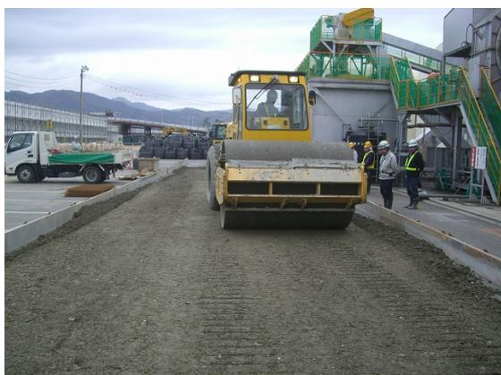
写真-7 振動ローラーによる転圧締め
