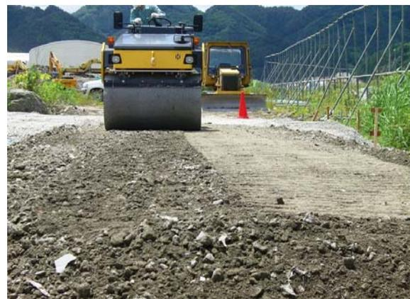
写真-4 振動ローラーによる転圧締め
