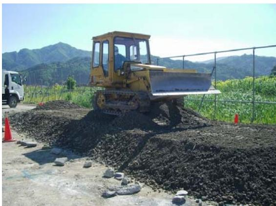
写真-3 ブルドーザによる敷均し
