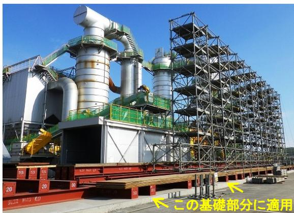
写真-5 セメント固化体の適用位置
