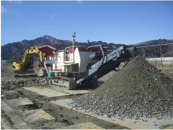
写真-1 破碎したコンクリートがれき
