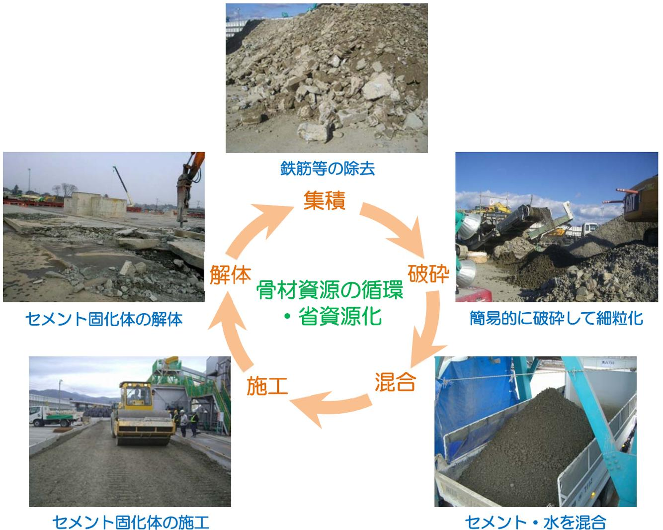
図-2 本技術によるコンクリートがれきの流れ
