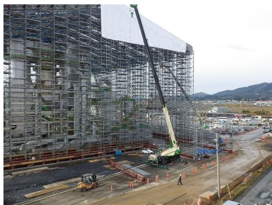
写真-8 大型仮設テント組立て状況
