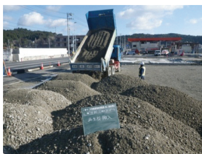
写真-4 運搬状況
