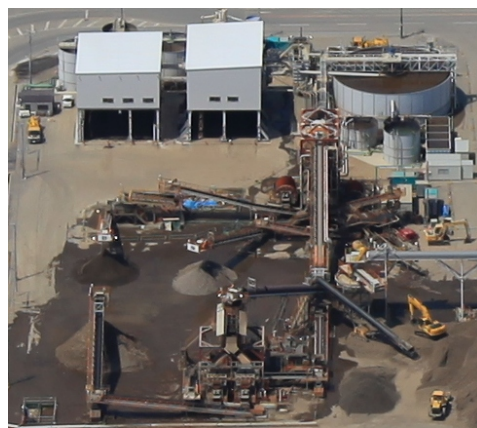
写真 3-3 分級洗浄施設全景(ふるい下)
