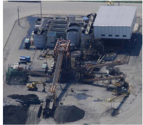
写真 4-2 分級洗浄施設全景(津波堆積物)
