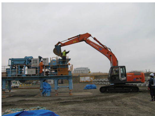
写真-8 コンクリート廃材の投入状況
