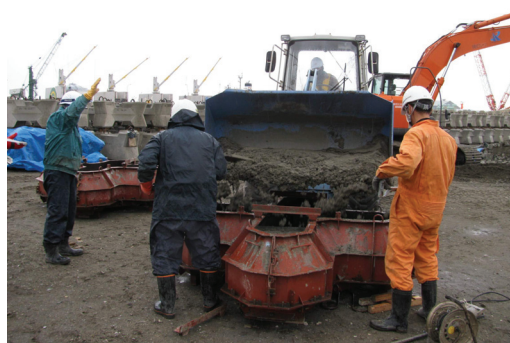
写真-9 打設状況
