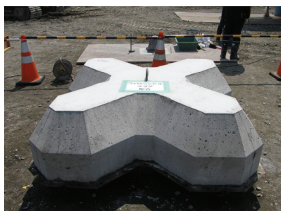
写真-13 打設後のブロック
