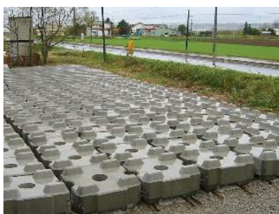
写真-3 根固めブロック（開発局）
