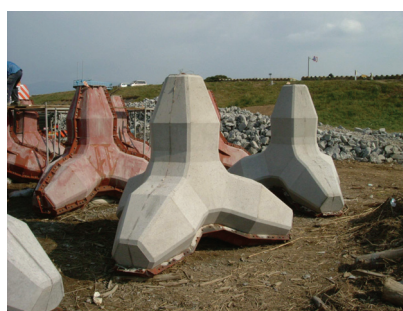
写真-4 消波ブロック（中部地整）
