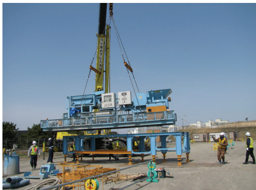
写真-6 専用装置設置状況
