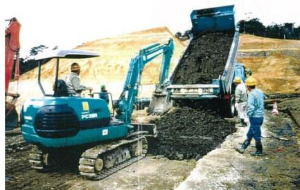
図-6 路床改良工事への適用例 (敷均し状況)
