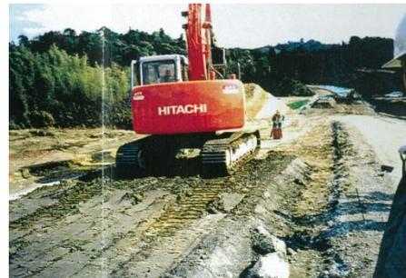
図-7 路床改良工事への適用例 (転圧状況)
