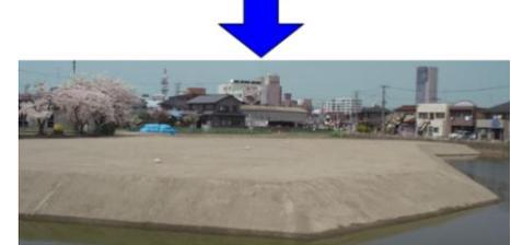
実施工場においても、乾湿繰返しによる劣化がなく、改良土が崩壊しない。
