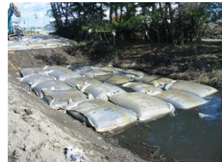
写真1 冠水箇所への盛土状況
