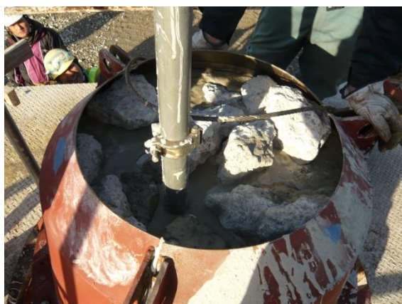
図-2 モルタル注入の様子と完成した消波ブロック
