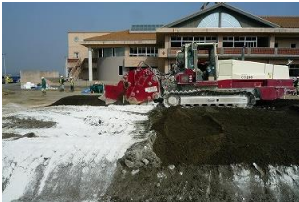
スタビライザーによる津波堆積土砂と不溶化材混合
