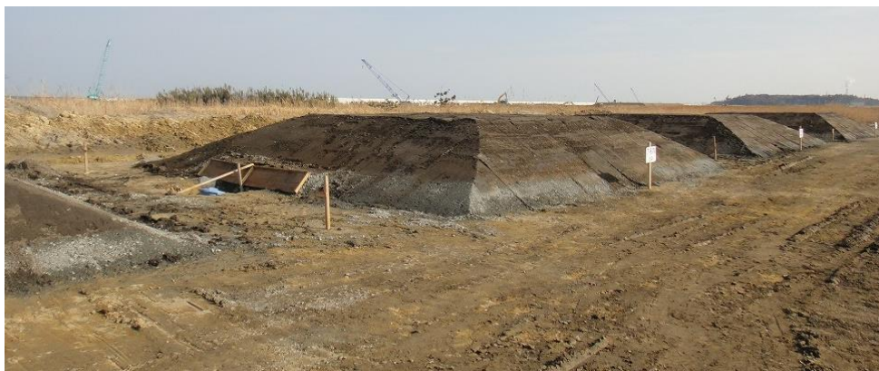
山元町 盛土試験状況
